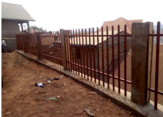
Gjerdet på toppen av muren
