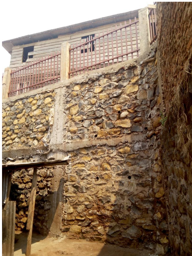
En del av den ferdige støttemuren
