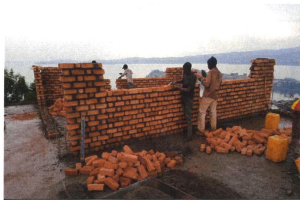
Blokk 1, andre etasje under oppføring
